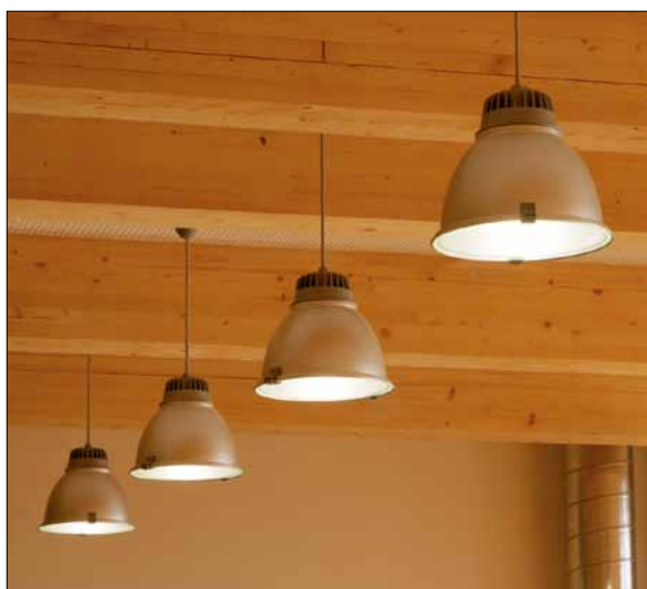
Obr. 5. Difuzor světlo dostatečně rozptýluje a zajišťuje rovnoměrné osvětlení
