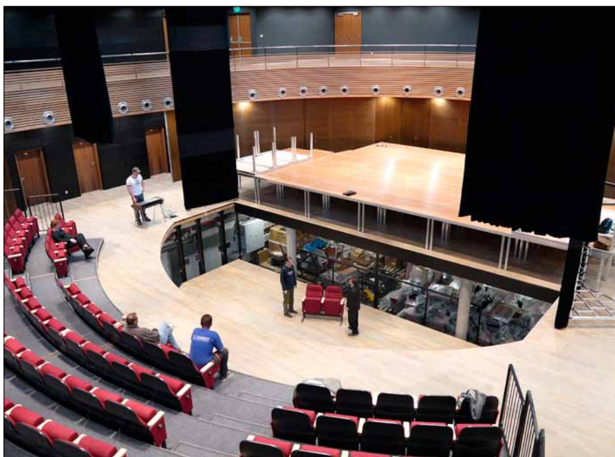
Obr. 7. Jeviště se zvedacími stoly (na spuštěném zvedacím stole vlevo Martin Kenkuš, technický ředitel InterSono SG, vpravo Tomáš Borůvka, manažer provozu UFFO)
