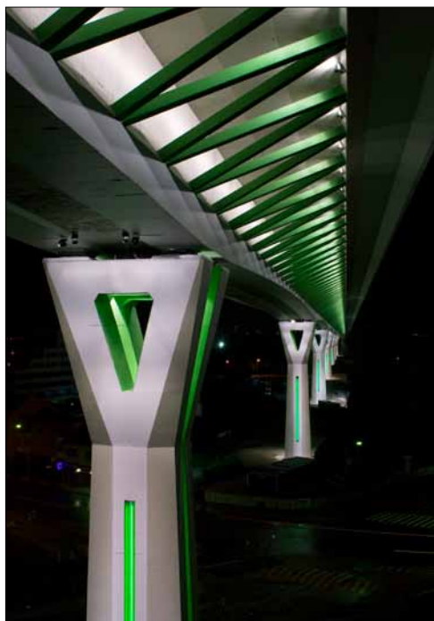
Obr. 2. Detailný pohľad na pilier a mostovku
