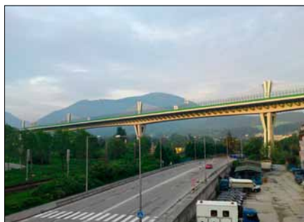
Obr. 1. Denný pohľad na stavebnú konštrukciu estakády
