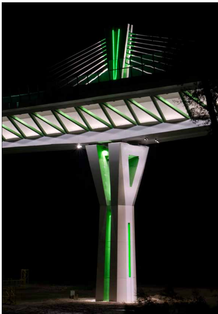
Obr. 4. Detail iluminácie závesných lán pylóna a rebier mostovky a piliera
