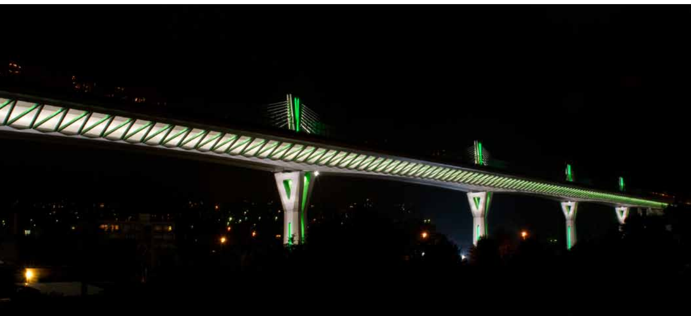
Obr. 3. Celkový nočný pohľad na osvetlenú estakádu
