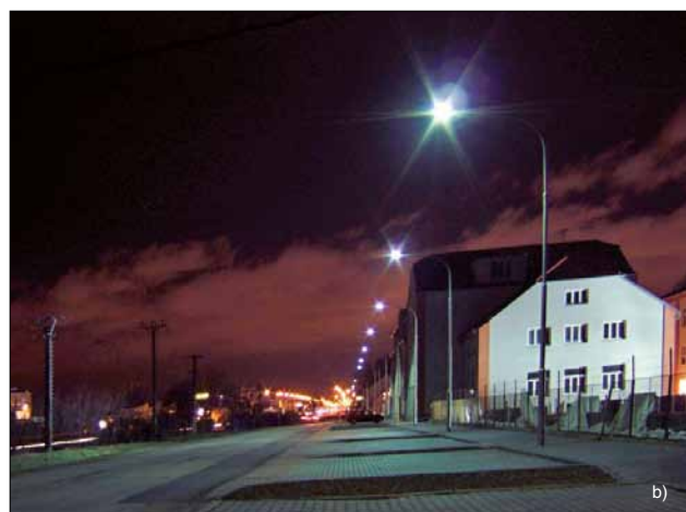
Obr. 1. Osvětlení ul. Kohoutova v Brně – Koleje J. A. Komenského (stožár SBD 4,5 žárově pozinkovaný + RAL, svítidlo SC 50 s plochým sklem)
