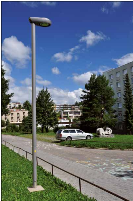
Obr. 1. Osvětlení ul. Kohoutova v Brně – Koleje J. A. Komenského (stožár SBD 4,5 žárově pozinkovaný + RAL, svítidlo SC 50 s plochým sklem)
