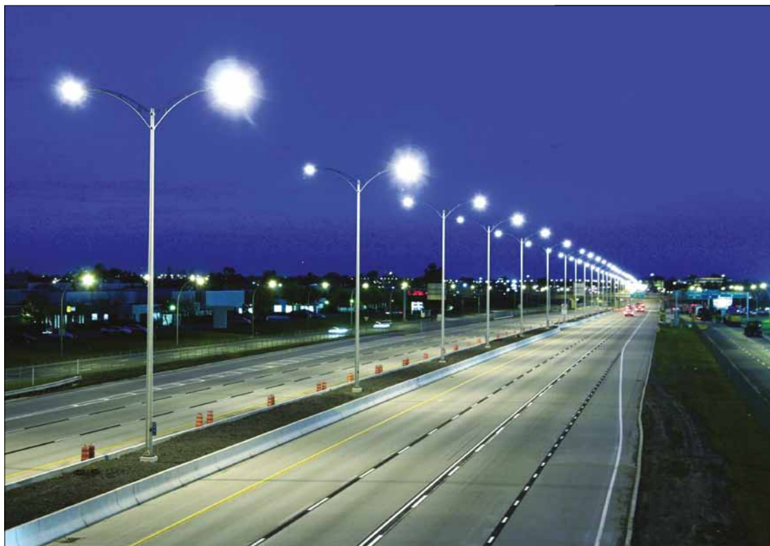
Obr. 5. Osvětlení svítidla s moduly StreetLight Advanced
