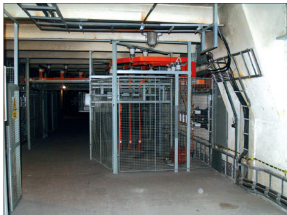
Obr. 3. Kabelový prostor TG 33
