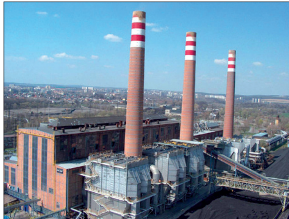
Obr. 1. Závod Elektrárna Třebovice s instalovaným výkonem 765 MWt a 180 MWe
