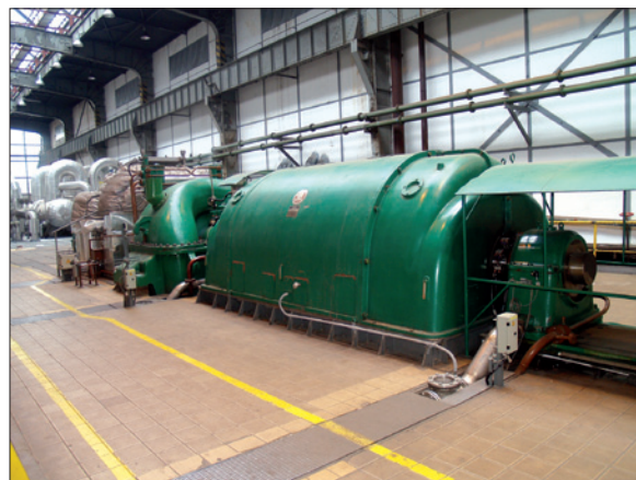
Obr. 2. Turbogenerátor TG 33 – 3f synchronní generátor poháněný parní turbínou, dvou pólový, jmenovité napětí 6,3 kV, jmenovitý činný výkon 33 MW, jmenovitý zdánlivý výkon 41,25 MV·A, jmenovitý maximální jalový výkon 17,7 Mvar, jmenovitý proud 3 780 A, jmenovitá frekvence 50 Hz
