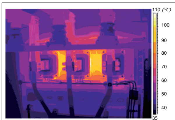
Obr. 5. Termogram místa před opravou (konstrukce z magneticky vodivého ocelového plechu)
