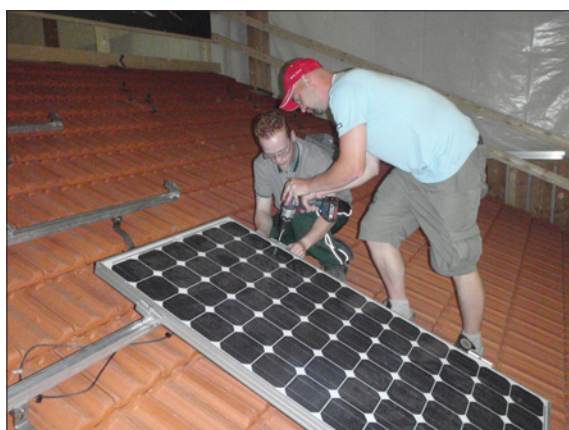
Obr. 2. Připevňování solárního panelu
