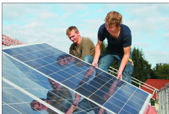
Obr. 1. Montáž na střeše
