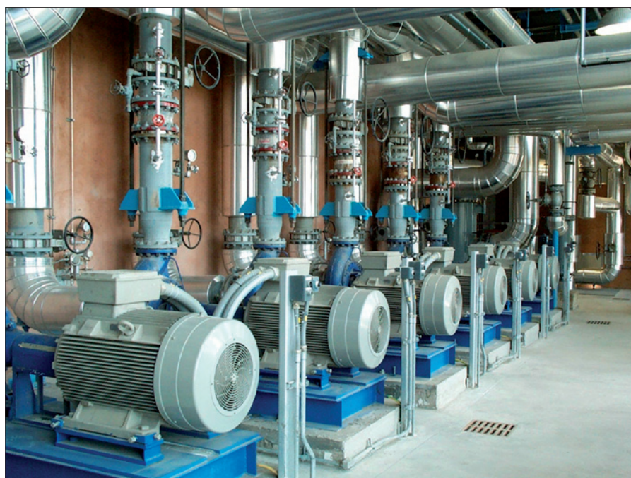
Obr. 3. Pro systémy s více čerpadly je ideální kaskádní řazení
