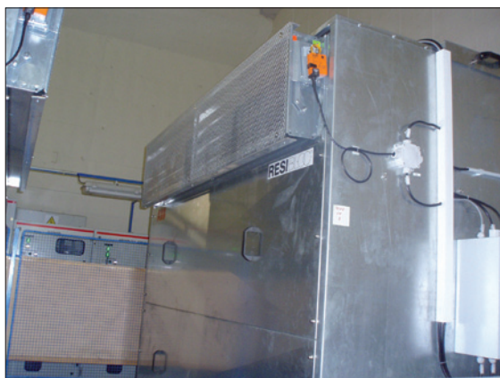
Obr. 4. Intenzifikace chlazení transformátorů při vyšších teplotách okolí
