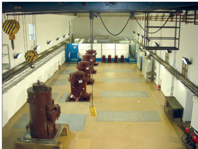
Obr. 3. Pohled do strojovny, v pozadí rozvodna vn s měniči
