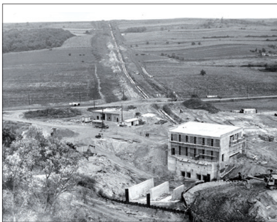
Obr. 1. Historický snímek z výstavby z roku 1967
