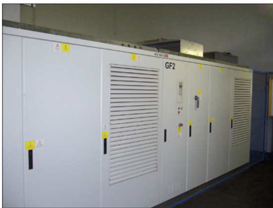
Obr. 2. Dva vedle sebe stojící vysokonapěťové měniče frekvence ACS 1000
