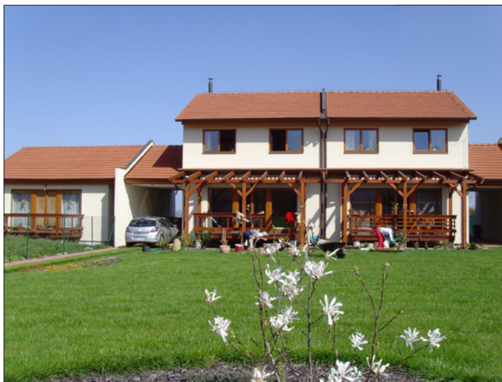
Obr. 2. Jižní strana tří řadových domů v roce 2010
