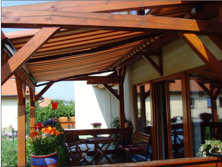
Obr. 3. Pohled na vysunutou markýzu
