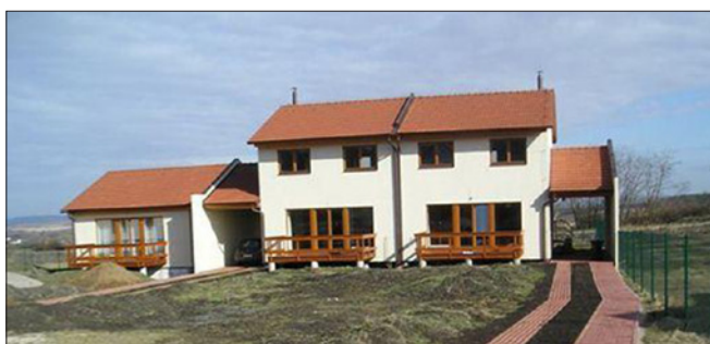
Obr. 1. Jižní strana tří řadových domů v roce 2006
