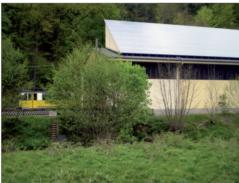
Obr. 2. Fotovoltaické panely na vozovně
