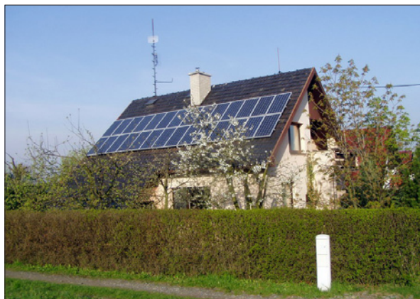
Obr. 2. Fotovoltaická elektrárna na rodinném domě v Lešné
