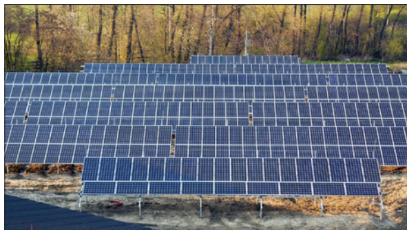
Obr. 1. Fotovoltaická elektrárna na volné ploše v Jeseníku n. O.
