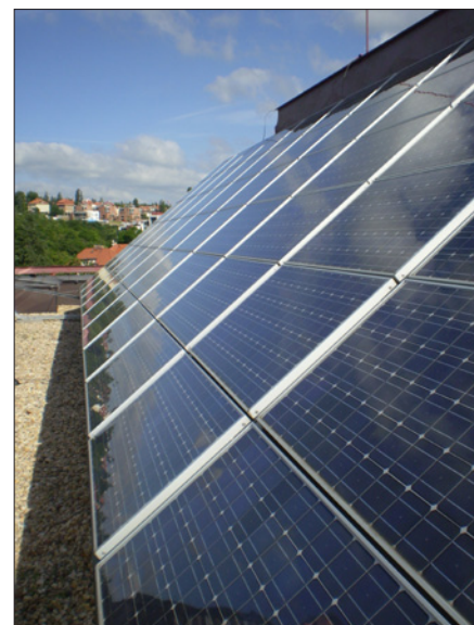
Obr. 2a. Fotovoltaický systém na střeše Fakulty stavební ČVUT v Praze
