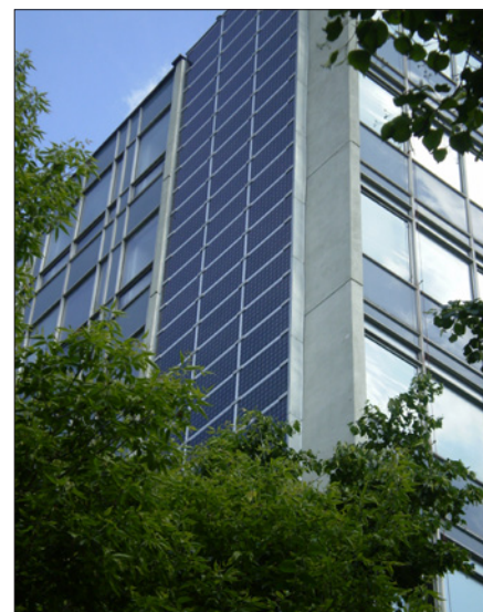
Obr. 2b. Fotovoltaický systém na fasádě Fakulty stavební ČVUT v Praze
