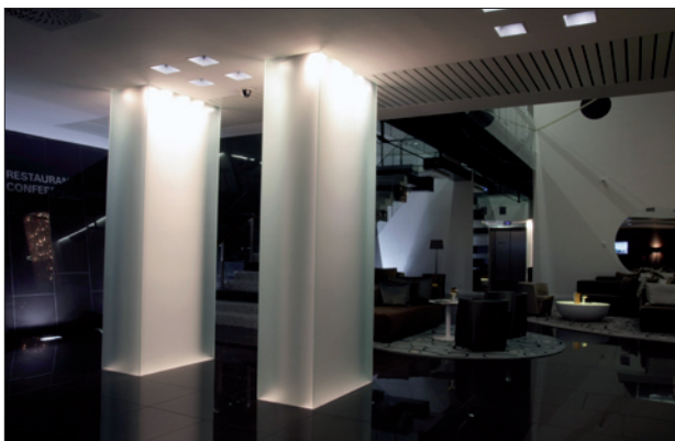
Obr. 2. Svietiace stĺpy so zabudovanými svietidlami Pleiad Square
