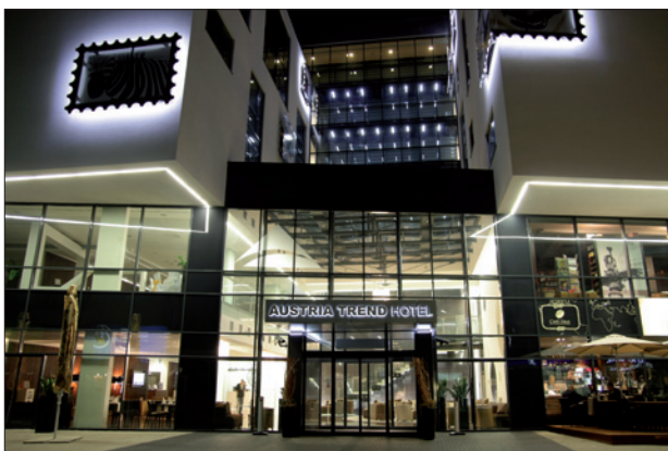
Obr. 3. Vstup do hotela so svetelnou líniou prechádzajúcou z exteriéru do interiéru a LED osvetlenie viditeľné na mostíkoch
