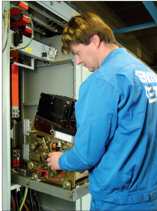
Obr. 2. Údržba jističe ARV1636
