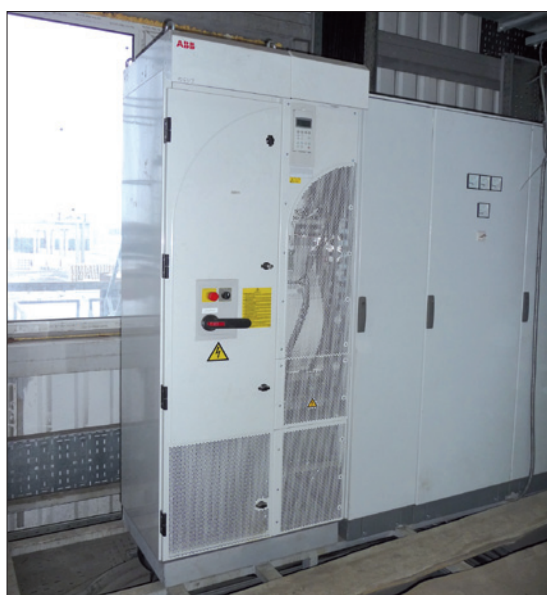
Obr. 4. Instalované měniče frekvence ABB typu ACS 800
