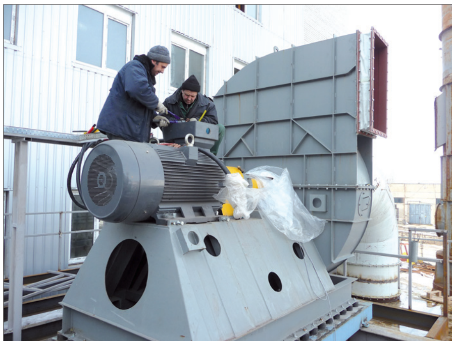
Obr. 3. Montáž motorů 200 kW
