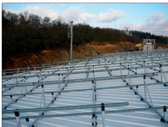
Obr. 2. Plastový nosný systém pro konstrukce FVE
