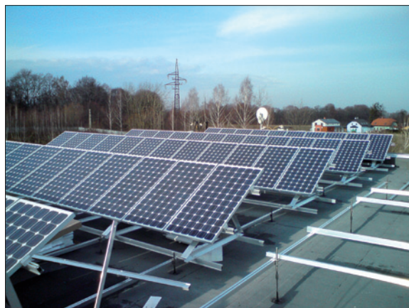
Obr. 1. Výstavba fotovoltaické elektrárny na střeše výrobní haly
