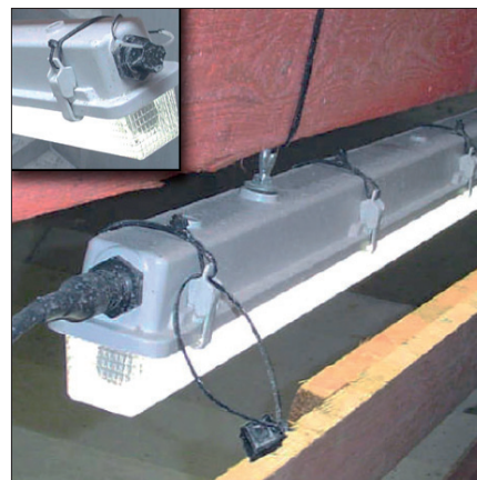
Obr. 7. Připojení prachotěsného svítidla pomocí gesisIP68; na detailu je vidět ochranná krytka konektoru na svítidle
