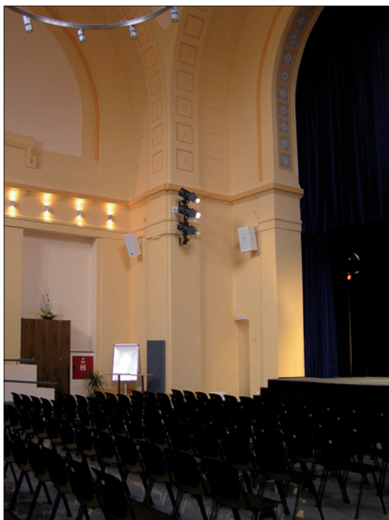
Obr. 4. Světlotromety Nota PC Plus s čočkou pebble-convex na svislé tyči osvětlují forbinu a přední část jeviště, bílé reproduktory D.A.S., vpravo typ RF-12.85, vlevo typ ARTEC-28 W
