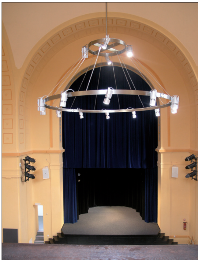
Obr. 3. Pohled na jeviště s forbinou, světlo-mety Nota PC a hlavní reproduktory D.A.S.; centrální lustr osazen výbojkovými světlo-mety, návrh Ing. arch. Hynek Bouček
