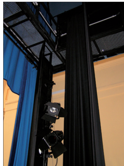
Obr. 6. Světlotromety Nota PC Plus s čočkou pebble-convex (ploskovypouklá čočka se zvrátním na rovině straně mající za následek rozptýlení světelného paprsku, její používání je více rozšířené v Evropě než v Severní Americe) umístěné na svislé tyči za kontraportálem, nahoře je detail technické lávky
