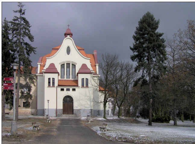
Obr. 1. Budova bývalého kostela, nyní multifunkčního kulturního centra
