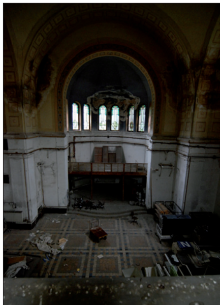
Obr. 2. Pohled na budoucí jeviště s forbinou před rekonstrukcí
