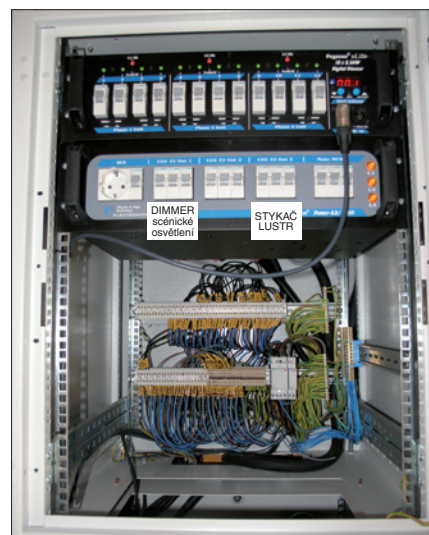
Obr. 7. Rozváděč scénického osvětlení osazený stmívačem Pegasus xLITE 100qs rise time filtr (hodnota odrušovacího filtru) rozvodna Pegasus Power-63/3 a svorkové pole scénického osvětlení
