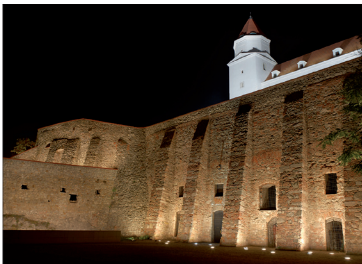
Obr. 4. Pohľad na vnútorné hradby a palác z Leopoldovho nádvorja
