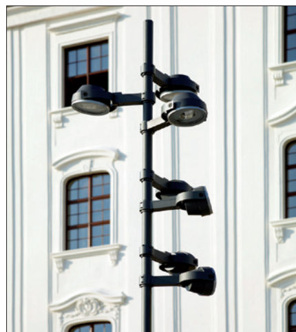
Obr. 7. Svetlomety Decoflood inštalované na stĺpoch
