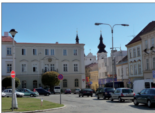
Obr. 2. Osvětlovací soustava na Horním náměstí před rekonstrukcí
