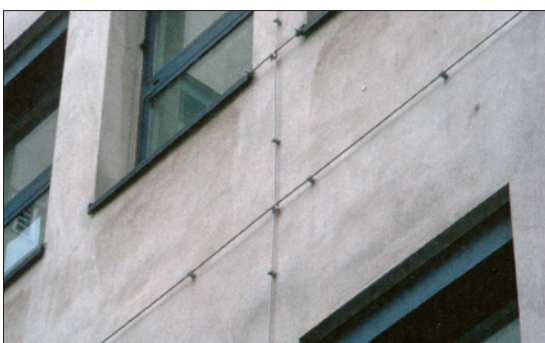
Obr. 1. Okružní vodiče instalované mezi svody rozdělují bleskové proudy, a vylepšují tak hodnoty dostatečné vzdálenosti s
