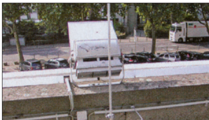
Obr. 4. Nesprávné uspořádání jímací tyče
