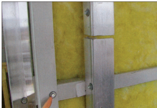
Obr. 2. Takovéto spodní konstrukce fasády nejsou pro bleskový proud propustné
