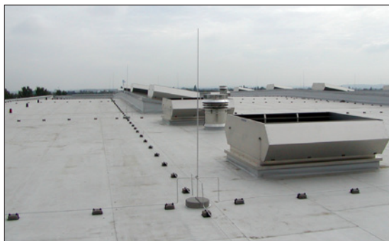
Obr. 3. Díky čtyřsměrnému přívodu jímací tyče je bleskový proud rozdělen do jednotlivých vedení a součinitel k_C je snížen na 0,25
