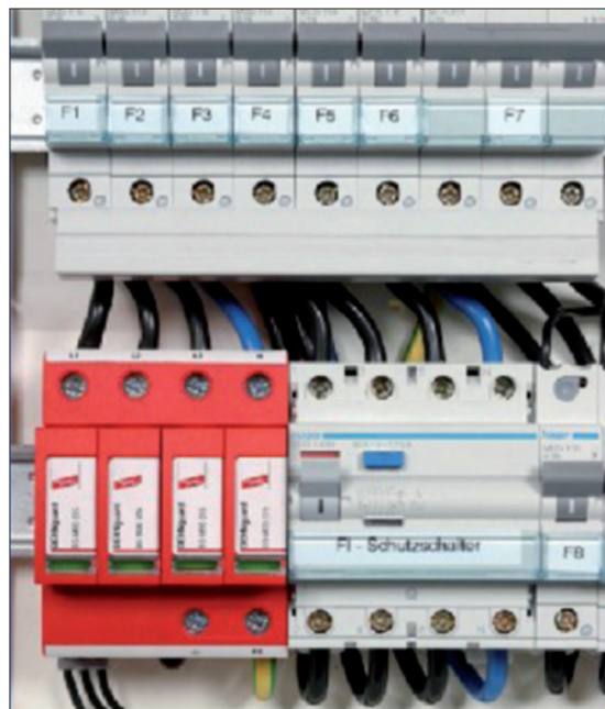
Obr. 1. Konkrétne pripojenie SPD vodičom s farbou izolácie zelená/žltá [1]
