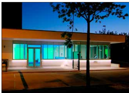
Obr. 1. Nová vstupní budova firmy OSRAM Opto Semiconductors je osvětlena jen světelnými diodami (Foto: OSRAM)
