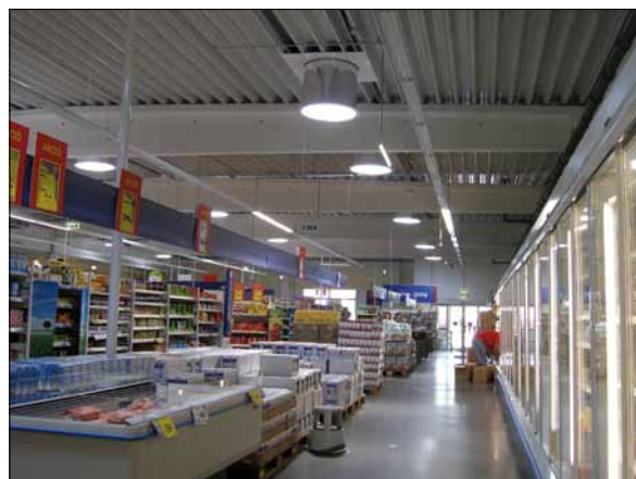
Obr. 5. Osvětlení sekce potravin prodejny Tesco v Ullu světlovody
