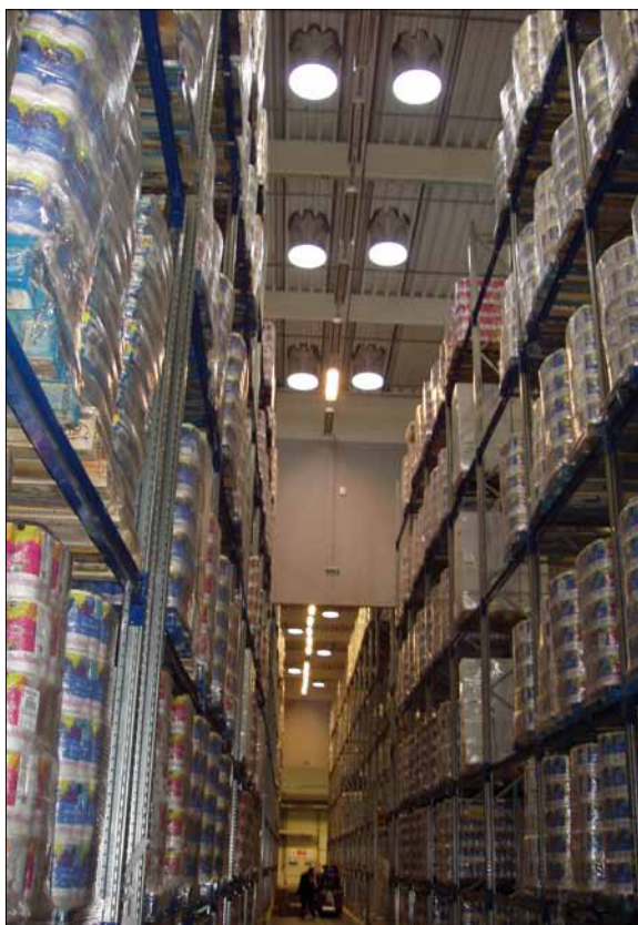
Obr. 2. Realizované osvětlení tubusovými světlovody skladu v maďarském Haceghalomu
