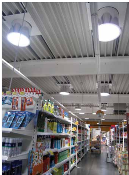
Obr. 6. Osvětlení sekce drogerie prodejny Tesco v Ullu světlovody
