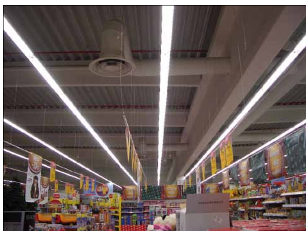
Obr. 4. Hypermarket v Ružomberku po instalaci regulace; v současnosti je regulace založena na hromadném rovnoměrném stmívání svítidel v celém prostoru
