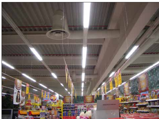
Obr. 3. Hypermarket v Ružomberku před instalací regulace; způsob regulace v minulosti spočíval ve vypínání části osvětlení
