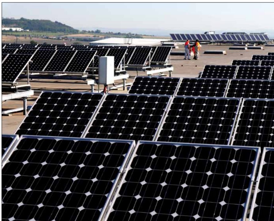
Obr. 1. Společnost Tesco Stores ČR vybudovala na střeše svého distribučního centra v Postřizíně fotovoltaickou stanici s celkovým výkonem 172 kWp
