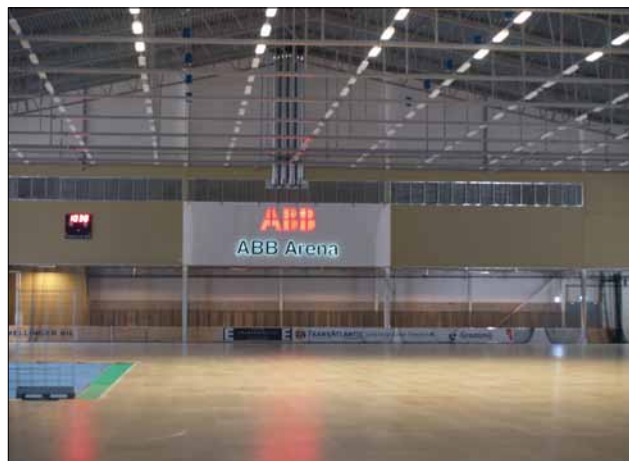
Obr. 3. Hala ABB s ukázkou segmentového osvetlenia časti haly pripravenej na iné športy
