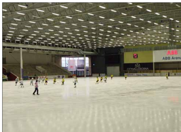
Obr. 2. ABB Arena vo Västerås s ľadovou plochou 105 × 60 m
