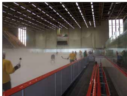
Obr. 4. Čiastočne zrekonštruovaný zimný štadión v Prievidzi so svietidlami Fagerhult Inducon 2 × 80 W osadenými vo výške 14 m
