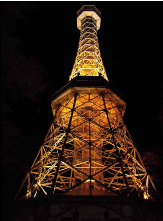
Obr. 4. Petřínská rozhledna Celá stavba je akcentována plošnými světlomety se sodíkovými výbojkami (teplota chromatičnosti asi 2 000 K) – spodní část horní konstrukce rozhledny s úzkým světelným svazkem; použité světlomety – Artechnic Schröder Neos 3, RD3 a Art004, instalované světelné zdroje Philips
