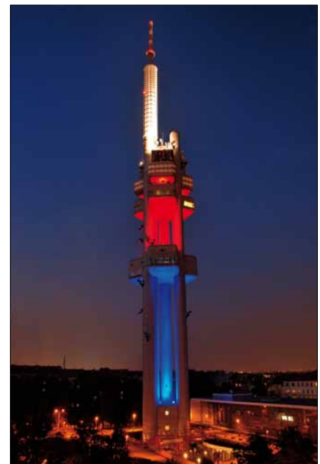
Obr. 5. Televizní věž Žižkov Barevné svícení červené, modré, bílé; dolní část věže modrá, střední červená a horní bílá; osvětlení symbolizuje českou vlajku; svítidla jsou opatřena barevnými filtry a světelnými zdroji s různou barvou a teplotou chromatičnosti; použité světlomety Artechnic Schröder Neos 3, instalované světelné zdroje Philips, Venture Lighting
