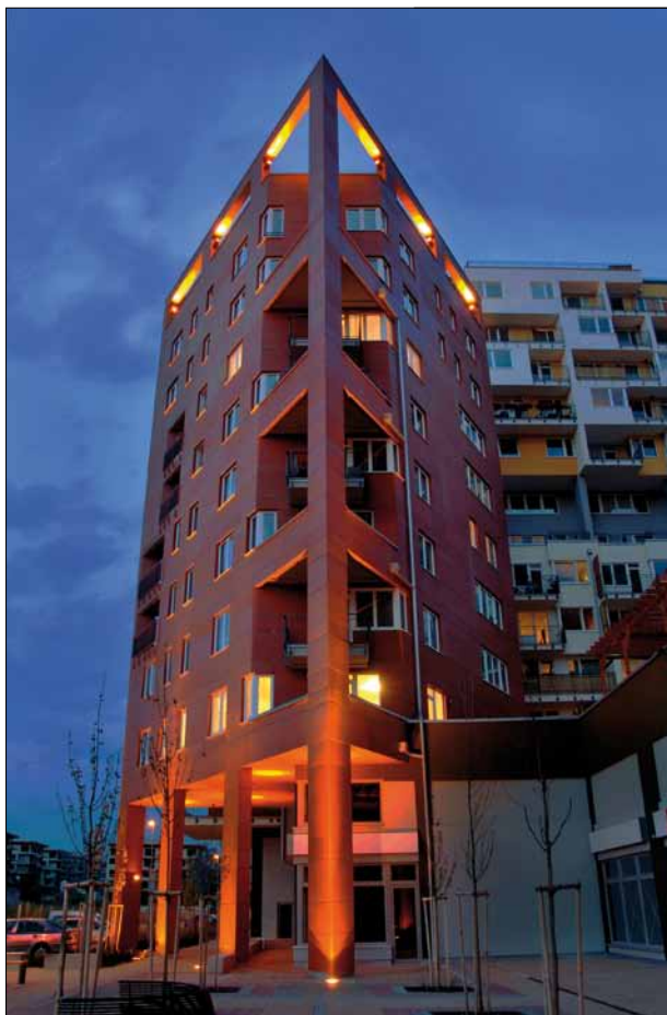
Obr. 7. Harfa Kombinace zemních svítidel osvětlujících fasádu domu a podlouhí s akcentací horní římsy budovy; použité světlometry Artechnic-Schröder Terra, Focal, instalované světelné zdroje Philips
