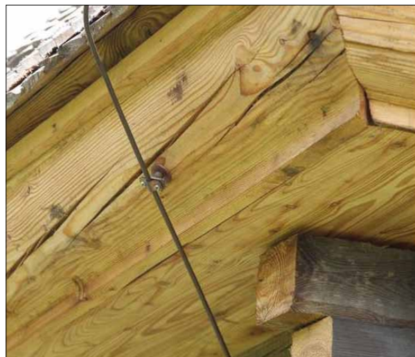
Obr. 1. Instalace svodu na dřevu
