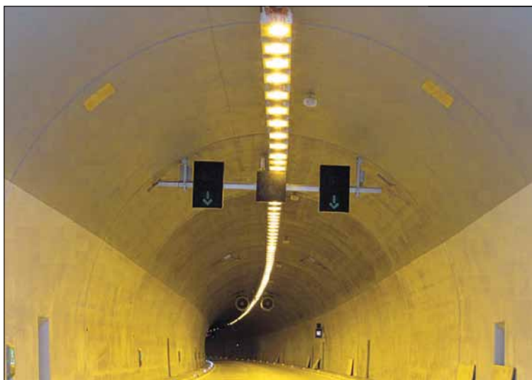
Obr. 1. Adaptačné osvetlenie v etape uvedenia tunela Bôrik do prevádzky
