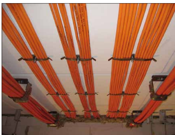
Obr. 7. Skupinové držáky OBO s požární funkčností
