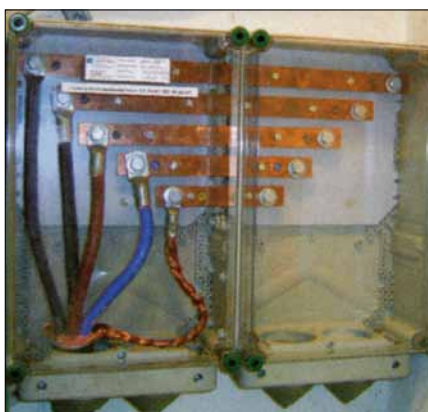
Příklad řešení – přípojková skříň pro mobilní zdroj nouzového napájení
