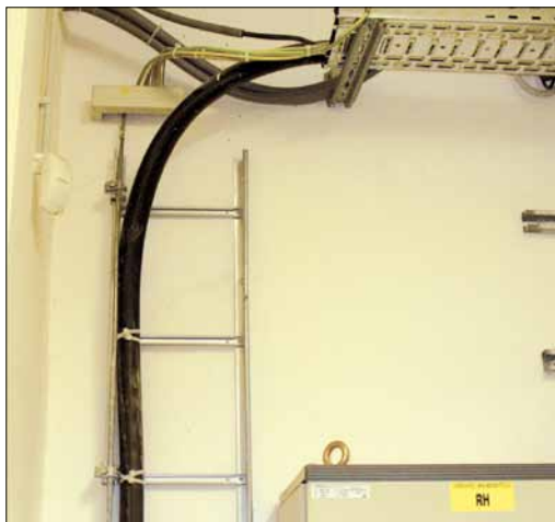
Obr. 1. Nie veľmi vhodné umiestnenie HUS
