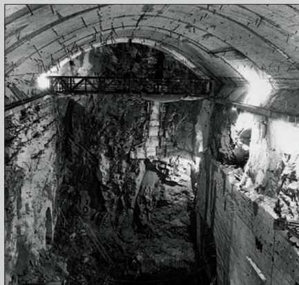
Obr. 2a. Výlom kaverny pro podzemní hydrocentrálu ve skále 160 m pod povrchem v roce 1957...
