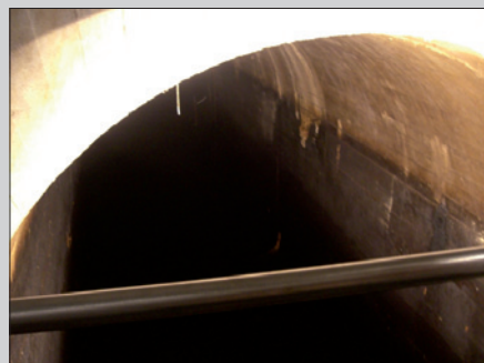
Obr. 6. Po odevzdání energie turbínám je voda odváděna 3,6 km dlouhým podzemním tunelem o průměru 7,5 m do vyrovnávací nádrže Lipno II ve Vyšším Brodě.
