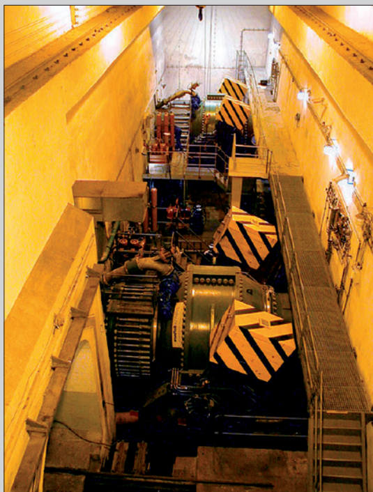
Obr. 4. Přívodní komory kulových uzávěrů o světlosti 2,5 m
