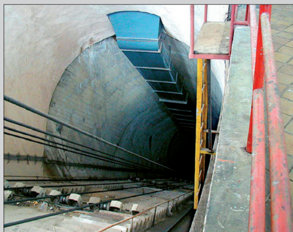
Obr. 8. Přístup do podzemní části elektrárny je šikmým tunelem o délce 210 m a sklonu 45° pomocí výtahu
