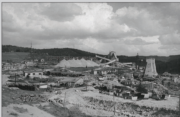
Obr. 1. Zařizováním staveniště v roce 1951 byla započata vlastní stavba vodního díla Lipno
