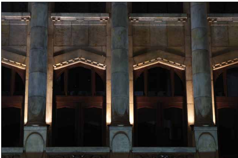
Obr. 6. U paty každého sloupu je dvojice svítidel D04 Hidro PAR-N
