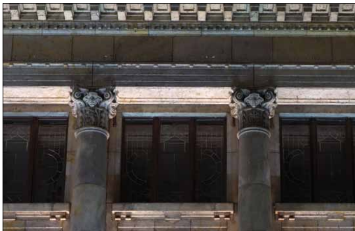
Obr. 4. Hlavice sloupů na východním průčelí
