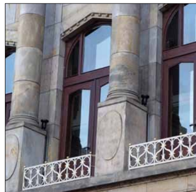
Obr. 6. U paty každého sloupu je dvojice svítidel D04 Hidro PAR-N
