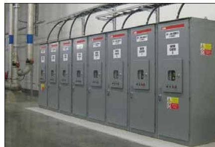
Obr. 3. Ve výrobním závodě HMMC Nošovice (Hyundai Motor Manufacturing Company) jsou aplikovány rozváděče NN i VN a rovněž transformátory VN/NN z provenience ABB
