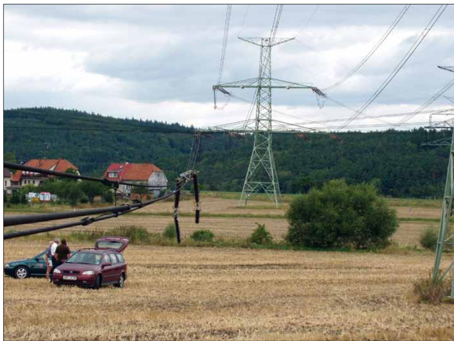
Obr. 4. Situace po pádu vodičů 400 kV na zem
