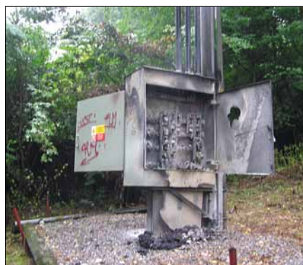
Obr. 6. Rozpojovací skříň nn po požáru
