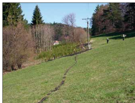
Obr. 5. Situace po pádu vodiče 22 kV na zem
