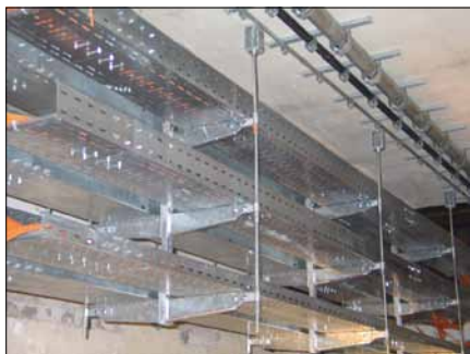
Obr. 1. Kabelový nosný systém před zkouškou požární odolnosti
