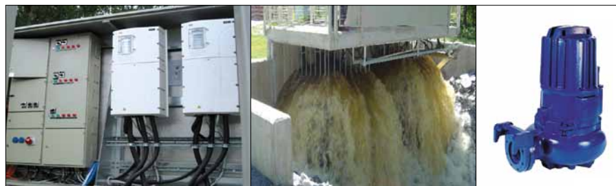
Obr. 3. Měníče frekvence ACS 800 pro jímky dešťové vody s čerpadly KSB 2x 80 kW
