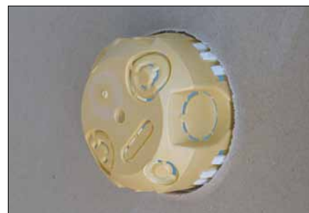
Obr. 4. Ukázka montáže krabice s montážním kroužkem
