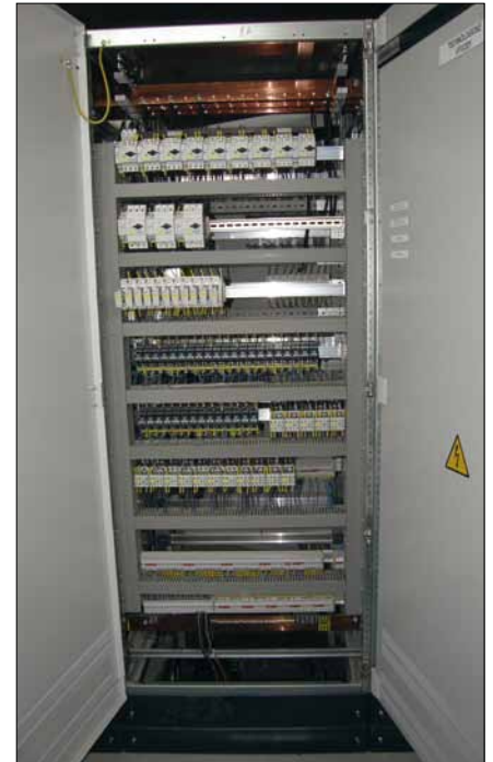
Obr. 8. Rozvodna nn firmy SAKO, a. s
