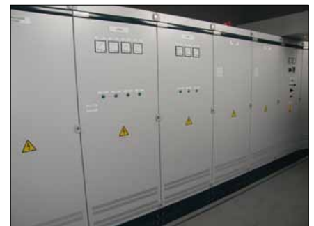
Obr. 9. Rozvodna nn firmy SAKO, a. s
