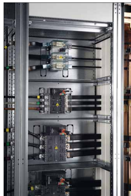
Obr. 3. Vnitřní prostory rozváděče – separace Form 4
