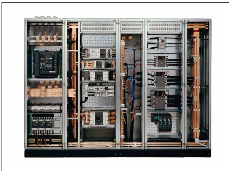
Obr. 1. Rozváděč Sivacon S4 s otevřenými dveřmi
