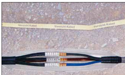
Obr. 9. Při uložení spoje hliník–měď do země chrání návlačky z lité pryskyřice spojovací místo před vlhkostí
