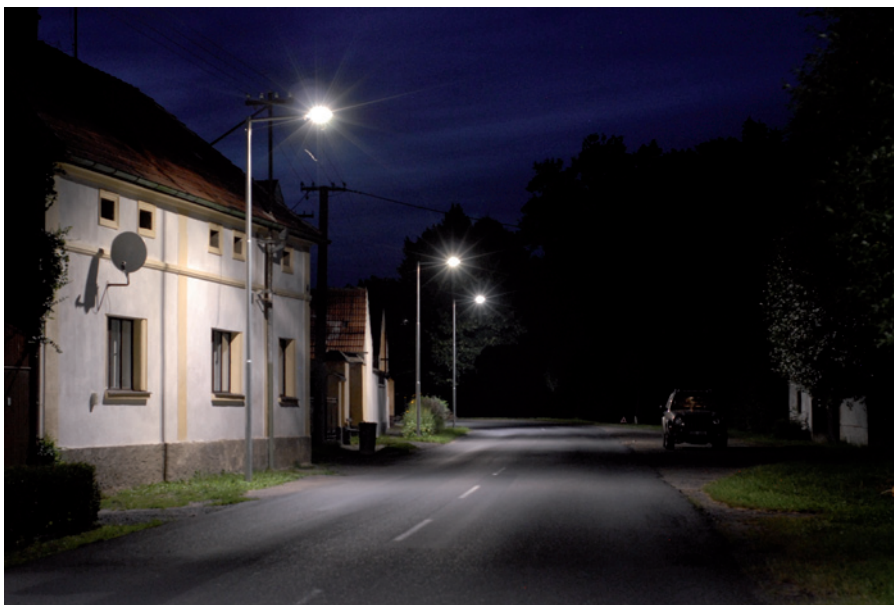
Obr. 6. Osvětlovací soustava LED – udržovaná osvětlenost je asi 3,5 lx, minimální 0,2 lx; tomu odpovídá rovnoměrnost 0,06 (pro připomenutí – nejméně náročná třída CE5 požaduje \bar{E}_m = 7,5 lx a rovnoměrnost 0,4)
