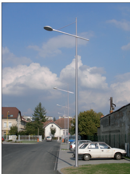
Obr. 4. Valašské Meziříčí, silniční hliníkové stožáry SAL Z-1 se svítidlem Cosmo, postupná výměna v tomto městě za zastaralé ocelové stožáry
