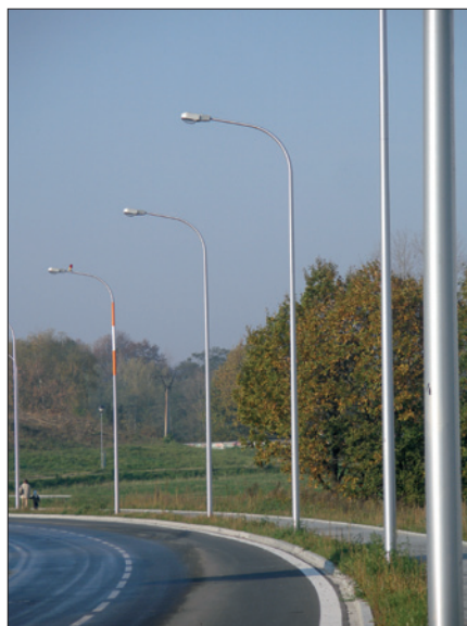
Obr. 2. Silniční hliníkové stožáry SAL 10, připezdová komunikace do Centra integrovaného záchranného systému Moravskoslezského kraje v Ostravě
