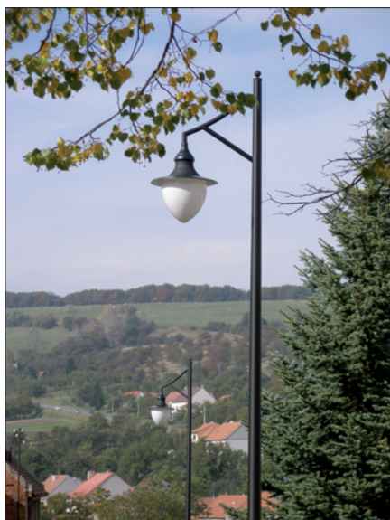
Obr. 5. Strání, parkové hliníkové stožáry SAL M-1 se svítidly OW Style, Cone; velmi vydařená realizace
