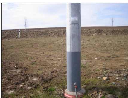
Obr. 5. Detail dolní části stožáru povrchově upravené ochranným termoplastickým povlakem
