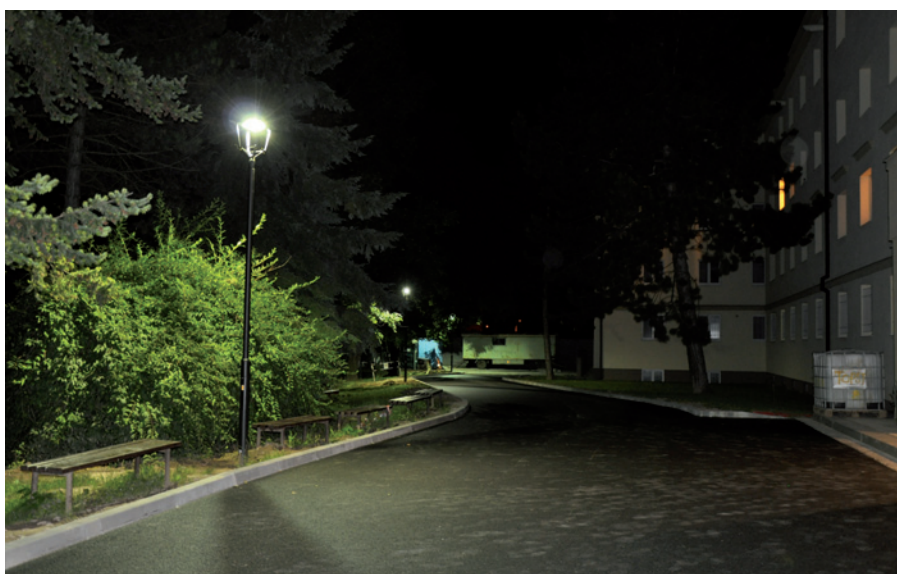
Obr. 8. Brno, Tauferovy koleje, ČR (použita svítidla CLM-V 70GC 1x HIT 70 W)
