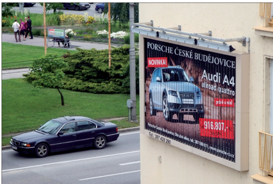
Obr. 6. Použití úsporných lineárních zářivkových svítidel LF4 258 ETRC k nasvícení reklamní plochy
