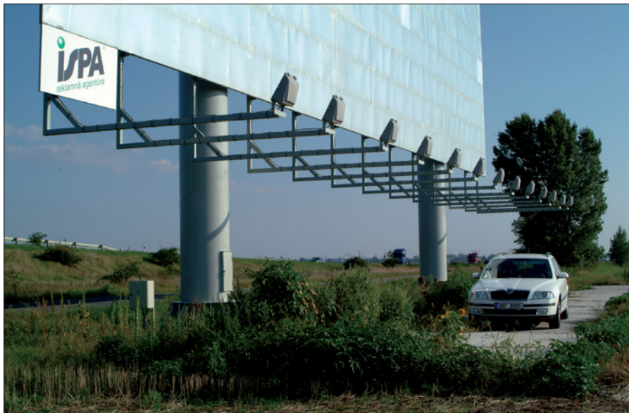
Obr. 4. Gigabillboard u slovenské dálnice se spodní řadou třinácti světlometů Leo/A 250 W CR
