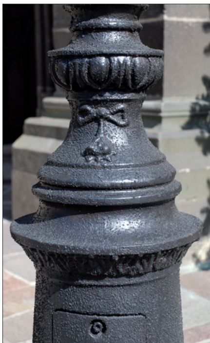
Obr. 4. Použitie antiplagátových náterov na historickom liatinovom stožiar
