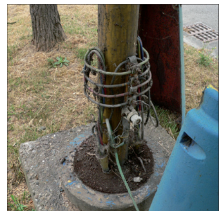
Obr. 3. Elektrovýzbroj verejného osvetlenia pred prevedením preventívnej starostlivosti
