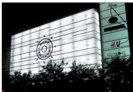
Obr. 1. Původně průhledná, prosklená fasáda OC Nový Smíchov byla potažena speciální světelnou fólií a podsvícena asi 700 lineárními zářivkami Radium
